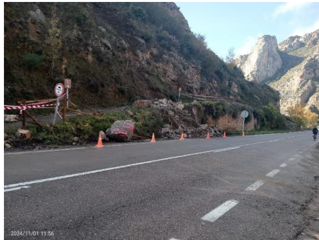
Zona donde se realizarán los trabajos de saneo.
