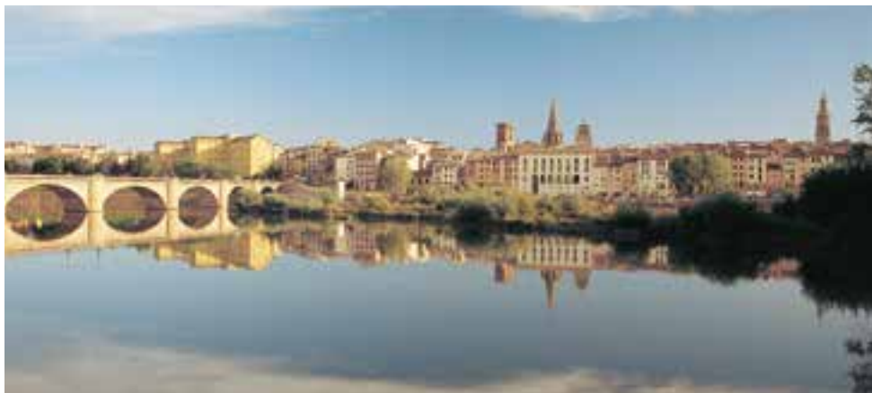
Puente de piedra, entrada del Camino de Santiago a Logroño.
